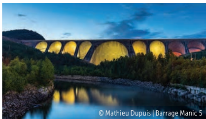
© Mathieu Dupuis | Barrage Manic 5
